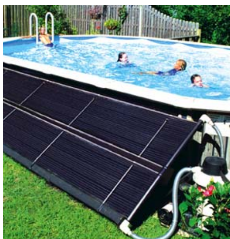
Figur 9. Eksempel på solfangere for oppvarming av utendørs svømmebasseng. Disse solfangerne har lav effektivitet fordi vannet som skal leveres ikke trenger særlig høye temperaturer.
