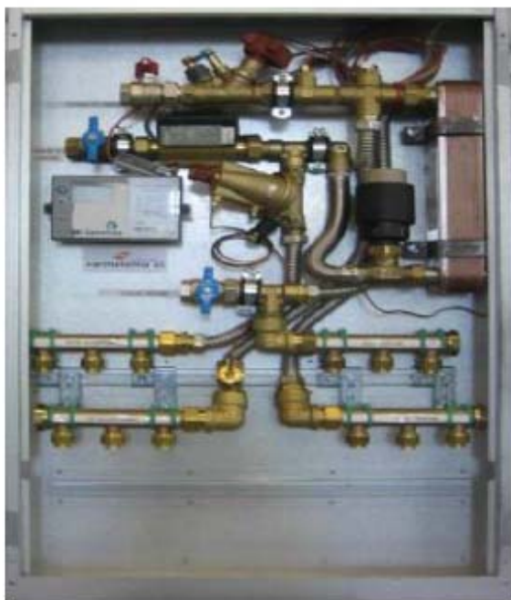
Figur 7.2 Fordelerskap m/komponenter. Kilde: Varmetema AS
